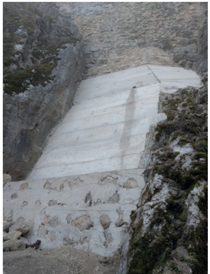
Sanierte Mauer im Nordwest Teil der Araburg.
