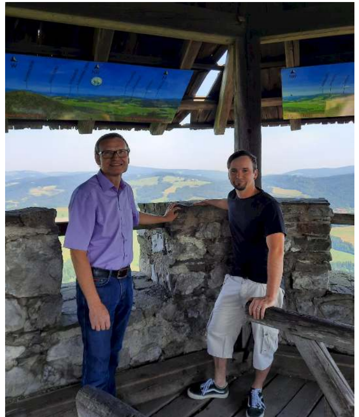
Vizebürgermeister Brandtner und Gemeinderat Lintinger begutachten die in die Jahre gekommene Dachkonstruktion
