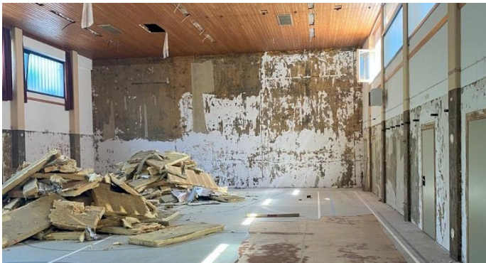
Wandteppiche, Bodenbelag und die alte Schwingboden-Unterkonstruktion wurden entfernt.
