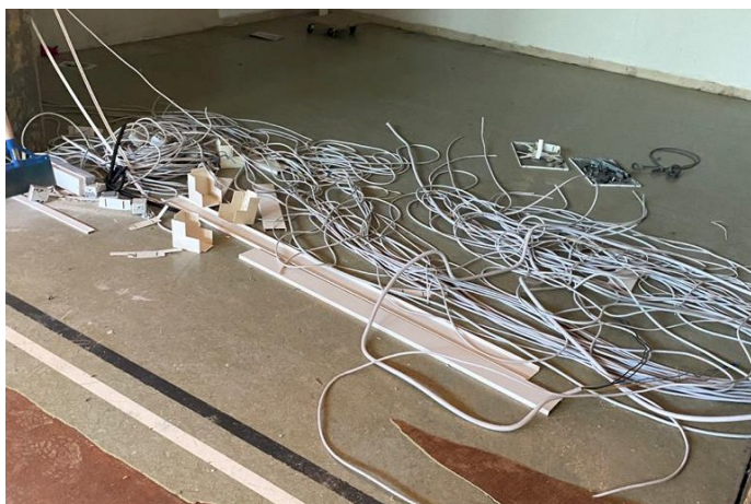
Alte Elektroinstallation wurde abgebaut und entsorgt.
