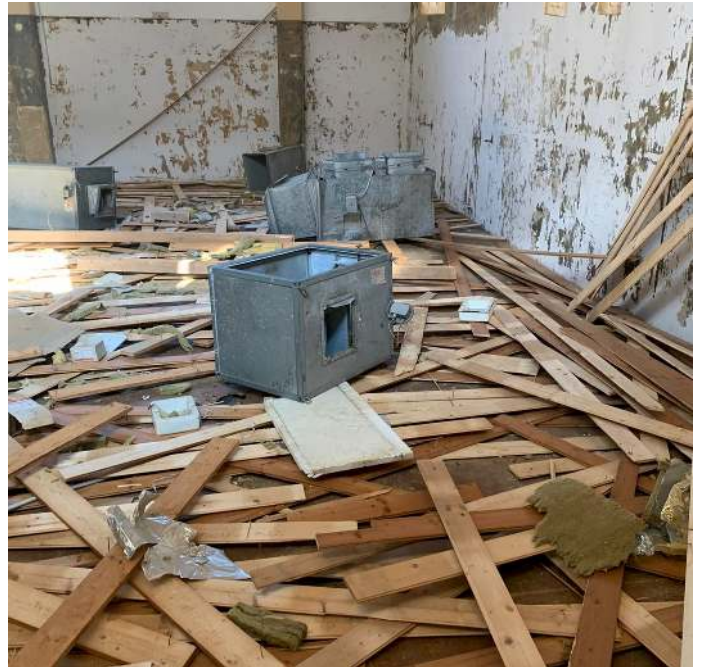
Auch Teile der alten Belüftungsanlage, die noch am Dachboden waren, wurden entfernt.
