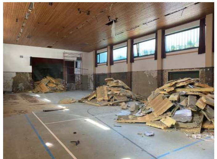
Die alten Baustoffe wurden getrennt und in eigens angelieferten Containern entsorgt.
