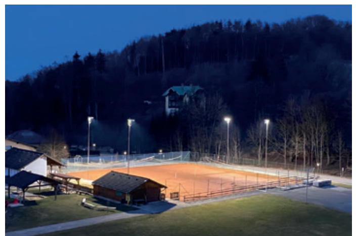
Die neue Fluchtlichtanlage wurde von der Union finanziert
