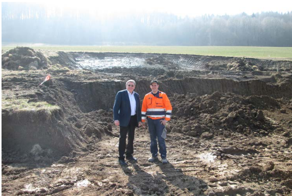
Bürgermeister Michael Singraber und Gemeinde-Vorarbeiter David Simon beim Lokalausguss der Baustelle.
